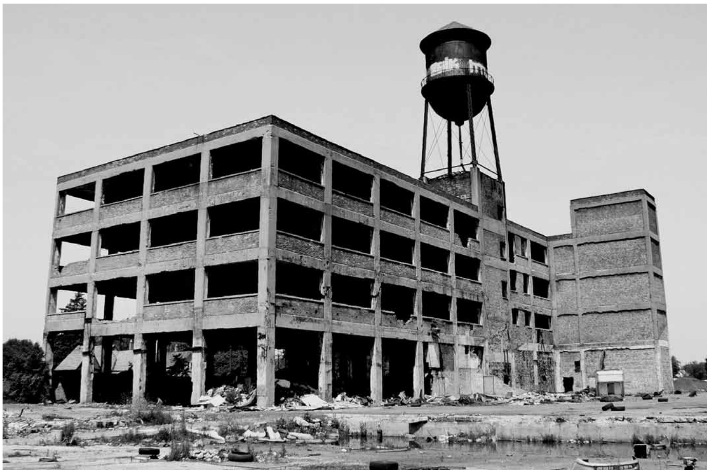
Fábrica abandonada em Detroit, EUA. Capital em excesso que precisa ser destruído para que a irracionalidade do sistema possa perdurar.
